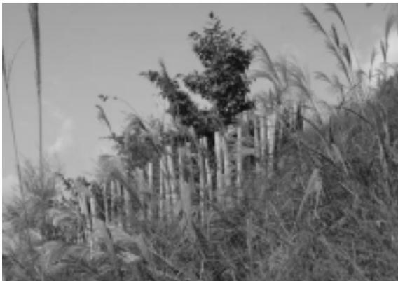
写真 4 . モウソウチクを用いた小型防鹿柵
